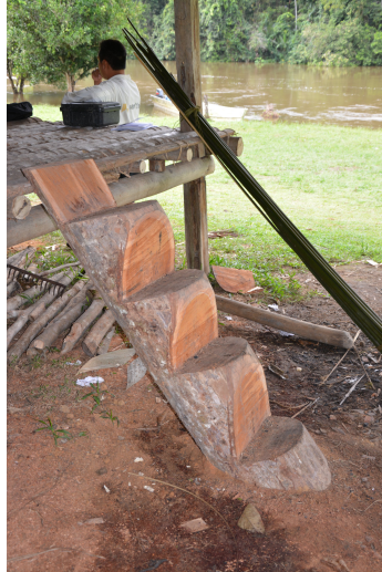
Escalier en Carapa réalisé pour le carbet de Yawapa - Créateur Laurent Pilaoukou (Guyane française)
